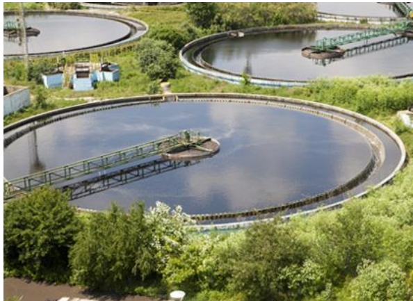
Notekūdeņu attīrīšanas iekārtu nosēddīķi (laukumveida avots)
